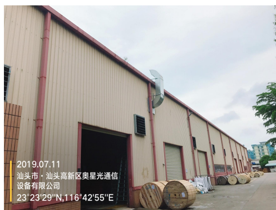
2#集中供料系统废气排气筒
